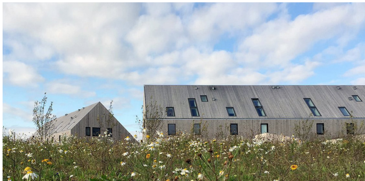
Dræk en mere naturbaseret byudvikling // Projekt: Længehusene i Nye, Aarhus, af LOOP Architects og Hune og Elkjær. Tækker Group er bygherre og udviklere af Nye. Fotograf: Ib Sørensen
