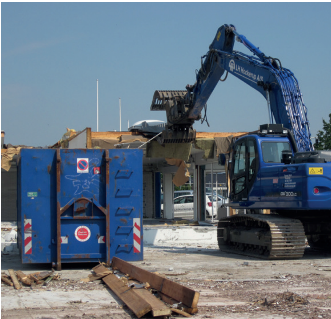
Nedrivning hvor affaldet sorteres umiddelbart.
