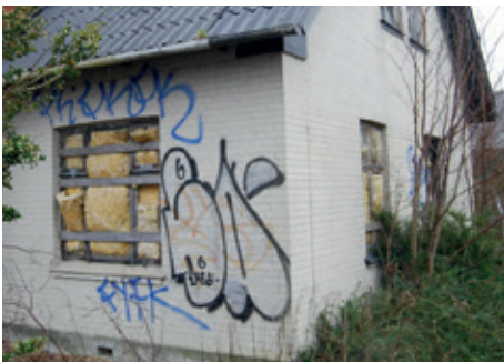
Kondemneret hus malet med blyholdig malmaling. Før nedrivning skal malingen renses af og opsamles for korrekt bortskaffelse.
