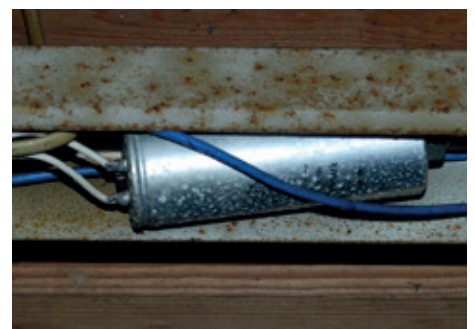
Ældre kondensatorer indeholder ofte PCB.
