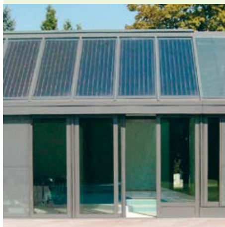
Eksempler som viser hvordan solfangeren kan nedfældes i taget. Billedet nederst viser ca. 10 - 12 m 2 solfanger.
