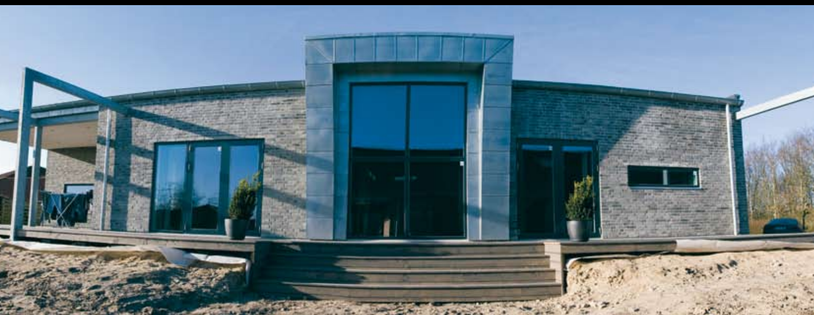
Foto: Sønderborg Kommune. Hus opført som energi plus hus. Huset har bl.a. solceller på taget og producerer mere energi end der forbruges. Huset her er fra Sønderborg og er opført af SIB.
